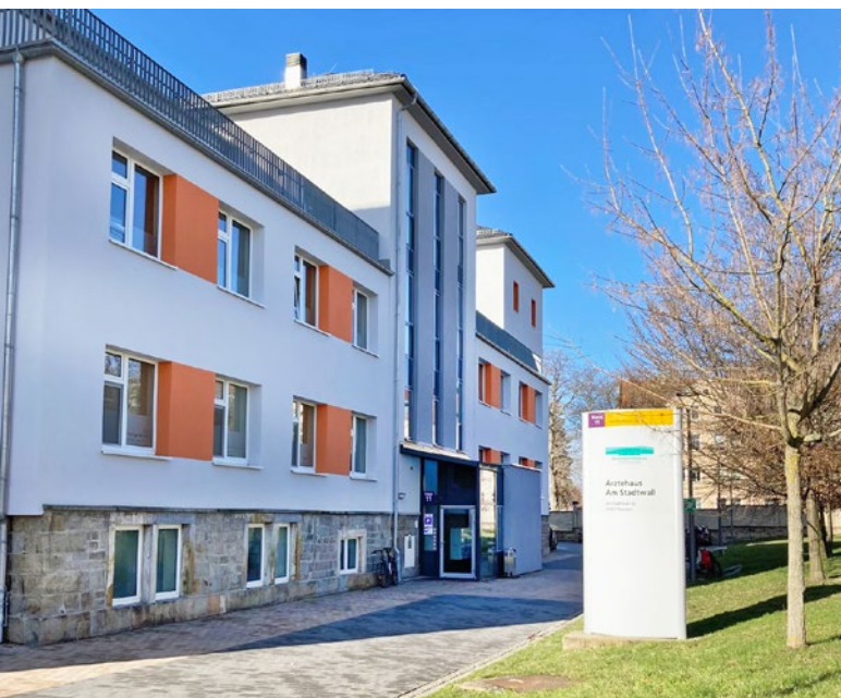
Das Ärztehaus, in dem die dermatologische Eigenpraxis liegt.
